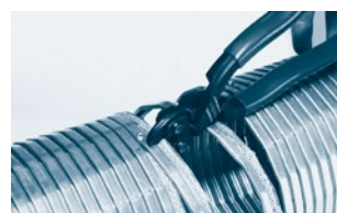
Schritt 3: Überstehendes Profil mit Bleischere oder Zange abschneiden.
